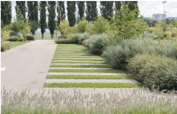
Exemple d'aménagement perméable avec bande de roulement
